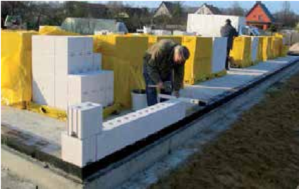
Mauerfußdämmung mit FOAMGLAS® PERINSUL unter Kalksandsteinen.
