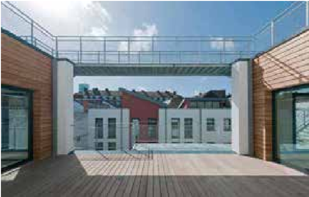
Wohnbebauung, LD2 Architecten, Brüssel. Foto Marc Detiffe
