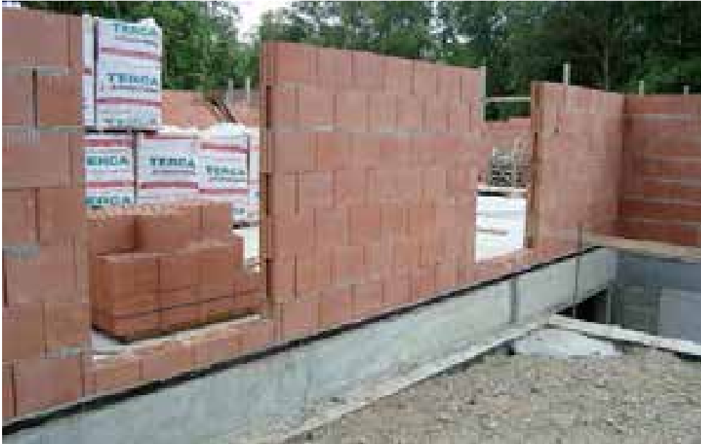
Mauerfußdämmung mit FOAMGLAS® PERINSUL unter Hochlochziegeln.
